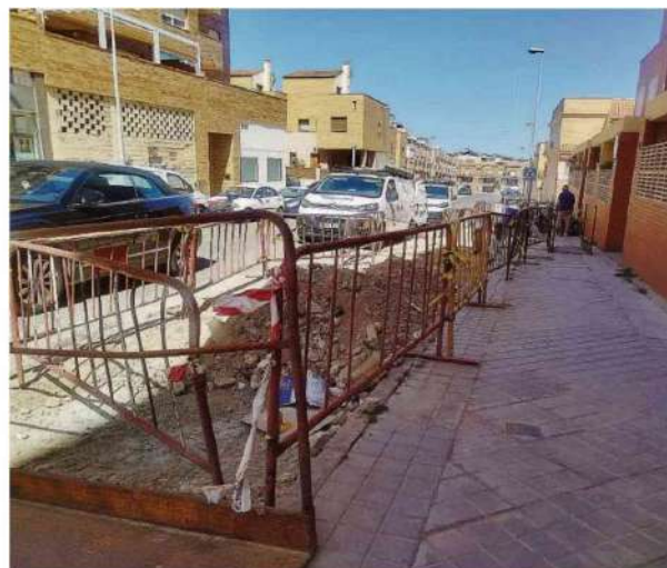
Obras en marcha en la calle Turquía de la capital. LA VOZ
