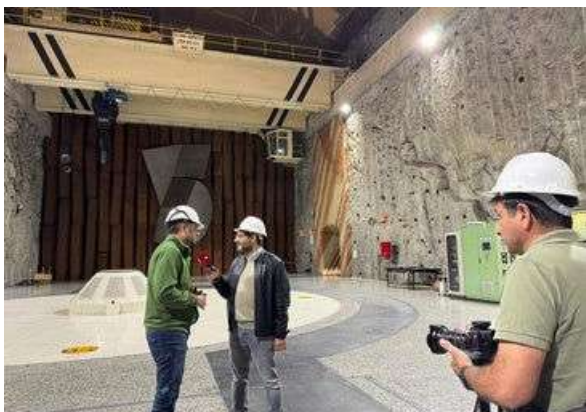
El equipo de Salamancahoy, este martes en la gran sala de las turbinas de Aldeadávila II.
