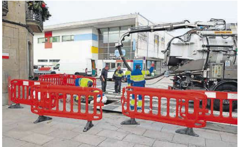
Imagen de unos trabajos de renovación de la red de abastecimiento en el centro de Bueu.
