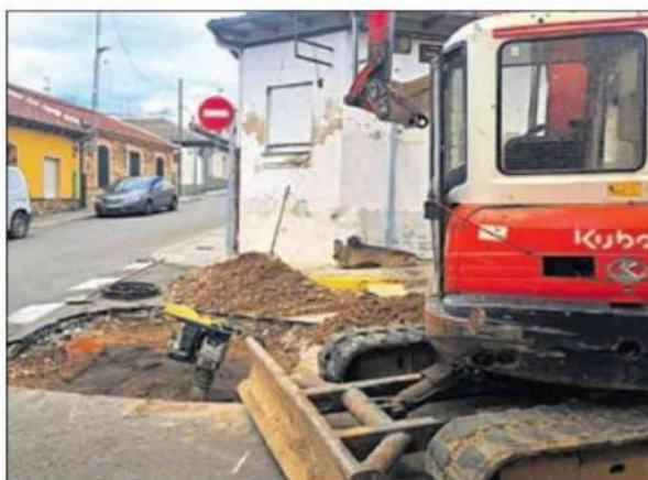
Trabajos en la red de agua y abastecimiento de La Bañeza. DL
